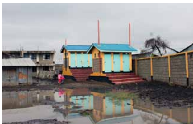
第一期改建工程已完成，但還有兩層的危樓教室、鐵皮屋辦公室和操場等需要整修。(楊玉華攝)
