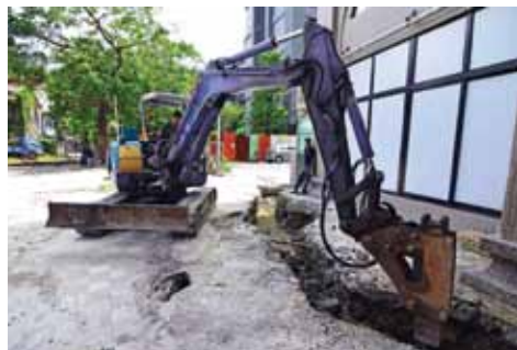
2015年7月8日開挖水溝。
